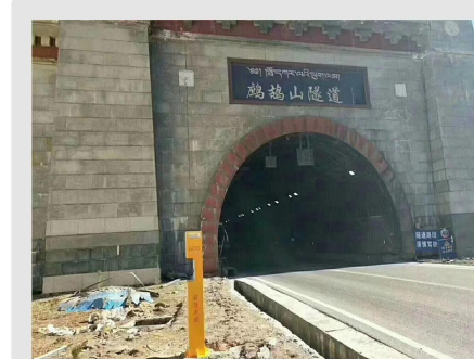
高原公路鸡鸣山隧道对讲系统
